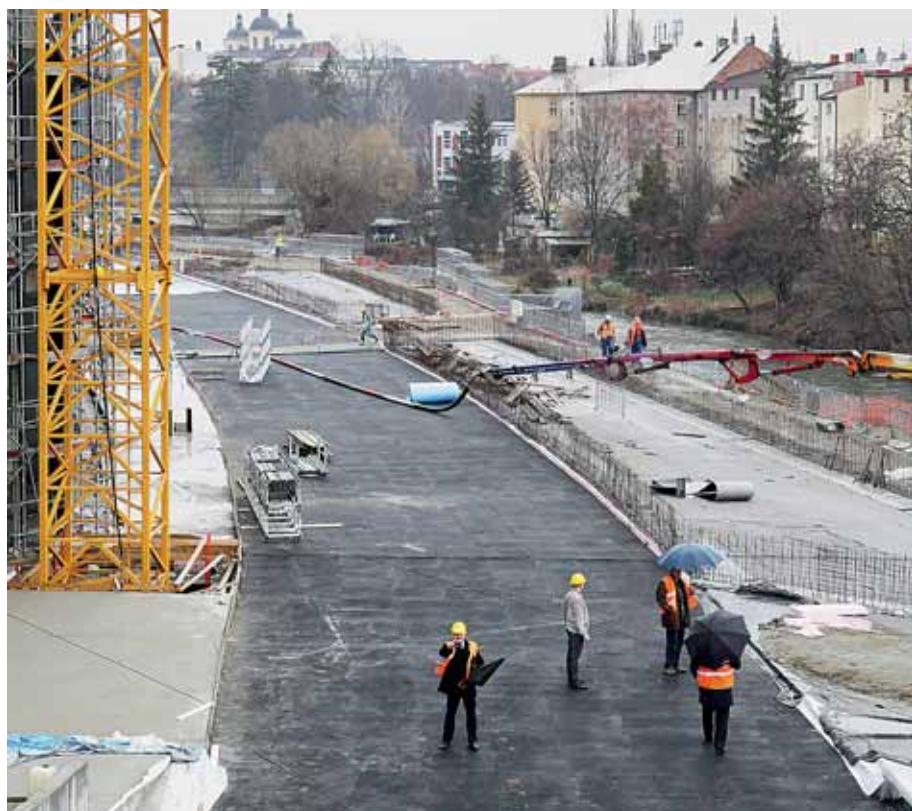
Stavba 1,4 kilometru dlouhé tramvajové tratě začala oficiálně 14. června 2012 poklepáním základního kamene v místě dnešní zastávky Šantovka.
