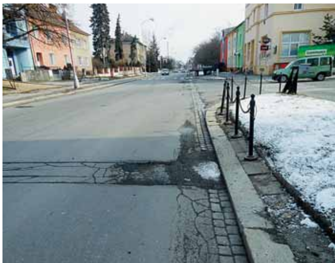
Ulice Polská před rekonstrukcí...
